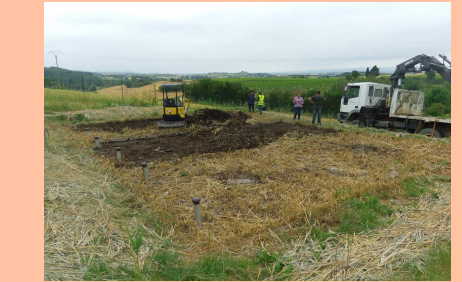
Curage de filtres à sable plantés de roseaux
