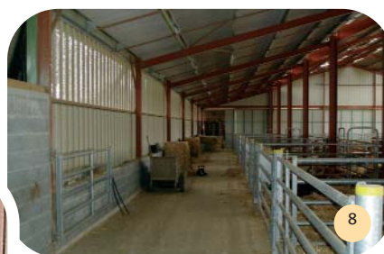
Le couloir à l'arrière du bâtiment est équipé de barrières pour la circulation des animaux.
