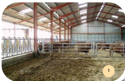
Vue générale de l'intérieur du bâtiment.
