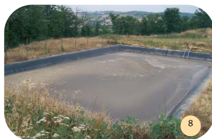
"Lagune" en géomembrane.
