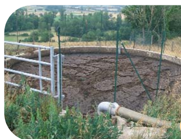
Fosse de décantation.
